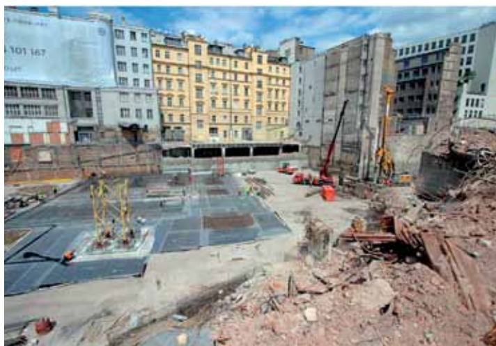
4 Pohled do stavební jámy; foto: Experimentální centrum FS ČVUT.
