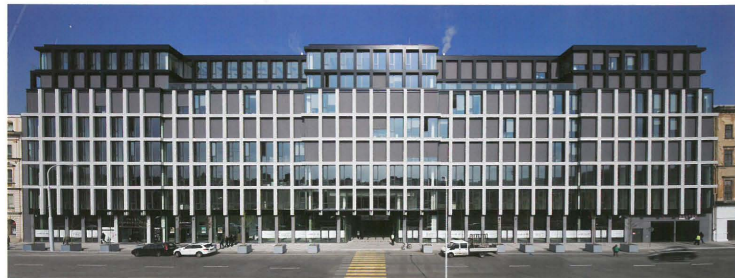
4 Pohled z ulice Na Florenci; jižní průčelí jsou opatřena vnějším stínícím systémem.
